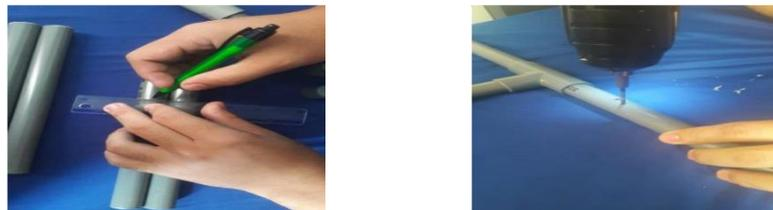
**RAJAH 6&7.** Proses Memasang Penyambung T, Penandaan Dan Membuat Lubang Dijalankan
